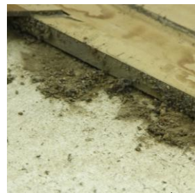
ภาพที่ 7: ภาพตัวอย่างความเสียหายที่เกิดจากฝุ่นและสิ่งสกปรกจากการขบถ่ายของหนูและค้างคาวที่มาอาศัยอยู่บริเวณด้านหลังของภาพเขียน ที่มา : จัดทำโดยนางสาวญานิศ ทองฉาย, เมื่อวันที่ 25 กุมภาพันธ์ 2563
