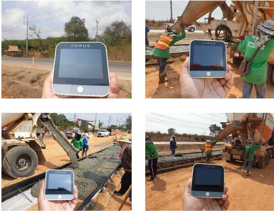
ภาพที่ 4 การเก็บปริมาณฝุ่นละออง PM2.5 การก่อสร้างผิวทางคอนกรีต
