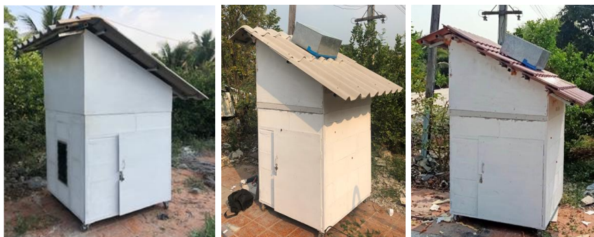
ก. บ้านจำลองหลังคากระเบื้องลอนคู่ ข. บ้านจำลองที่ติดตั้งปล่องระบายอากาศบนหลังคากระเบื้องลอนคู่
