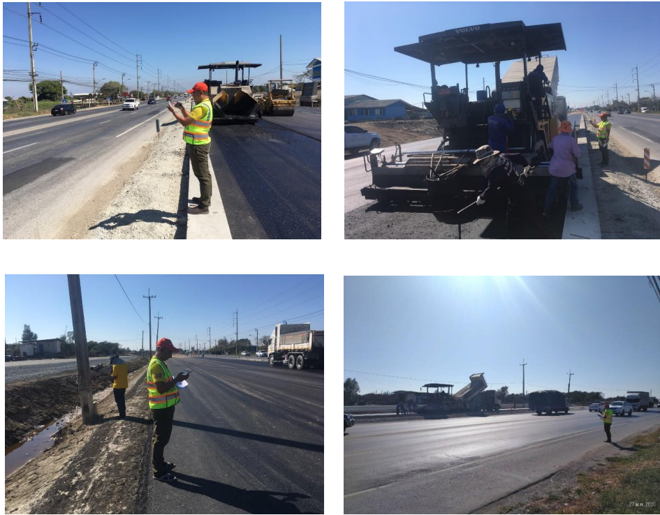
ภาพที่ 3 การเก็บปริมาณฝุ่นละออง PM2.5 การก่อสร้างผิวทางแอสฟัลต์ติกคอนกรีต
